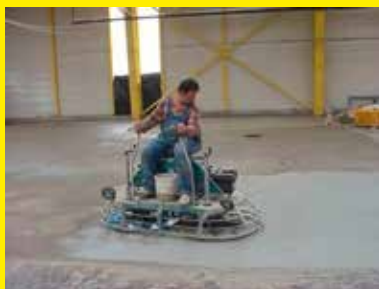
РИСУНОК 13. ЗАТИРОЧНАЯ МАШИНА («ВЕРТОЛЕТ»)
