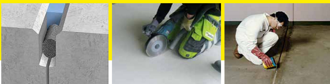
РИСУНОК 10. ПРОРЕЗАНИЕ ДЕФОРМАЦИОННЫХ ШВОВ И ИХ ЗАПОЛНЕНИЕ ШОВНОЙ МАСТИКОЙ
