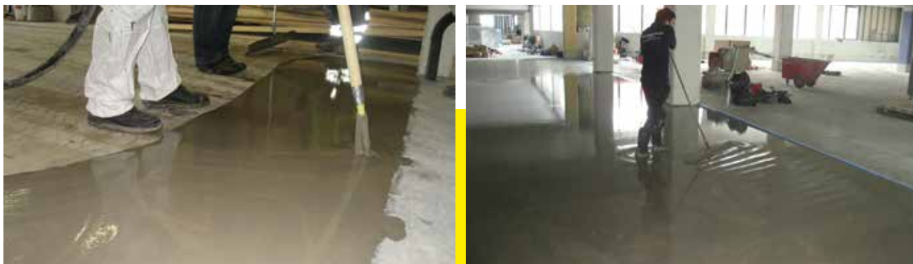
РИСУНОК 9. НАНЕСЕНИЕ НАЛИВНОГО ПОЛА
