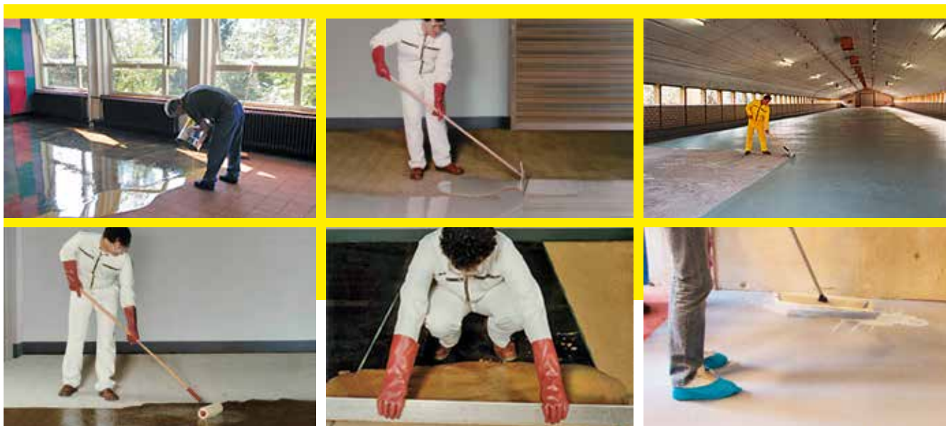
РИСУНОК 11. НАНЕСЕНИЕ ЗАЩИТНОГО ПОКРЫТИЯ ИЛИ ЭПОКСИДНОГО (ПОЛИУРЕТАНОВОГО) ПОКРЫТИЯ
